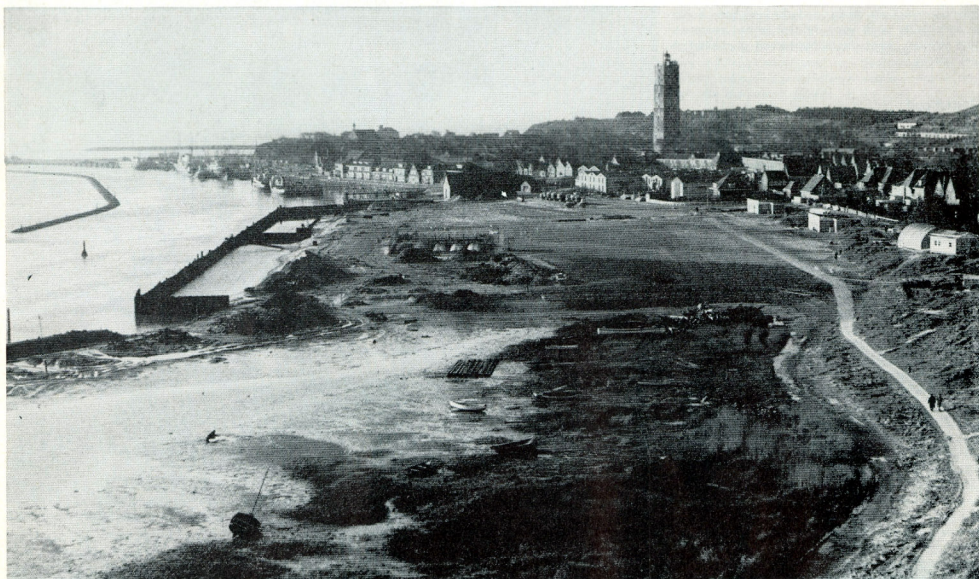
West-Terschelling, waar de Willem Barentszschool gevestigd is
